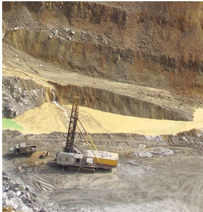
Slika 3-3. Bušenje minskih bušotina rotaciono-udarnom bušilicom Bucyrus Erie na površinskom kopu "Veliki Krivelj" RTB Bor
