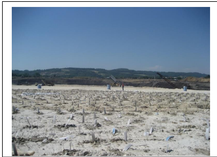
Slika 3. Sanacija unutrašnjeg odlagališta površinskog kopa Polje B primenom rešenja HUSKER
