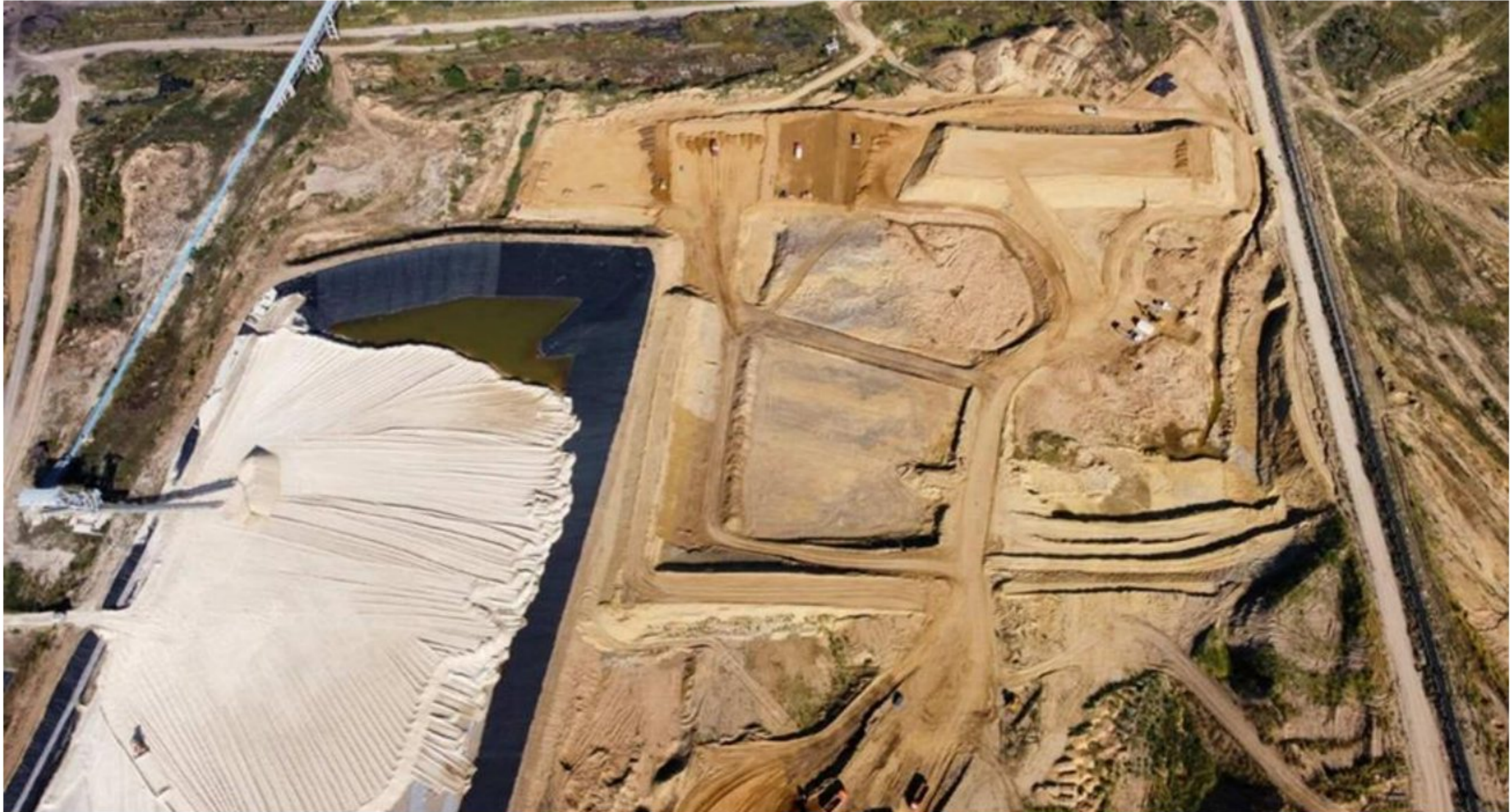
Слика 3.3.12 Изградња касета за депоновање гипса на унутрашњем одлагалишту површинског копа Дрмно [56]
