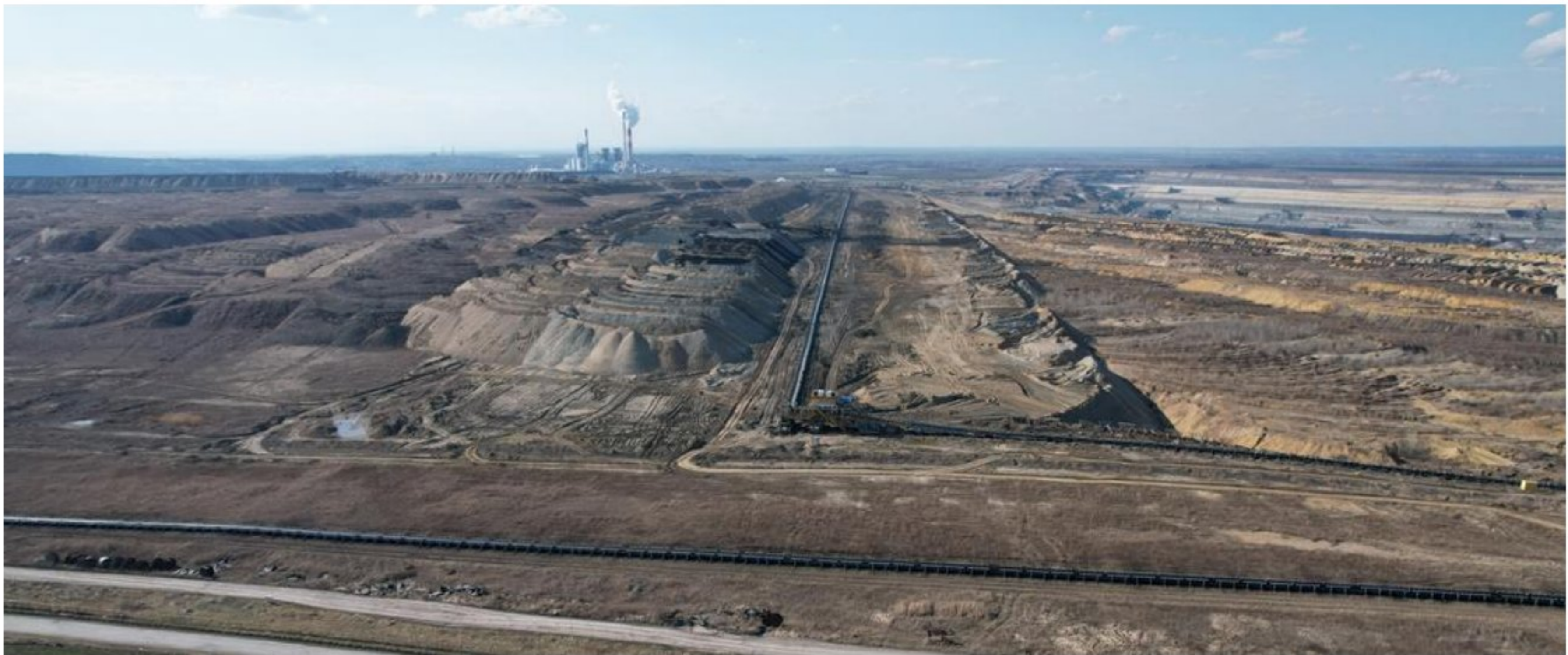
Слика 3.4.4 Рад одлагача формирањем дубинске и висинске подетаже [43]
