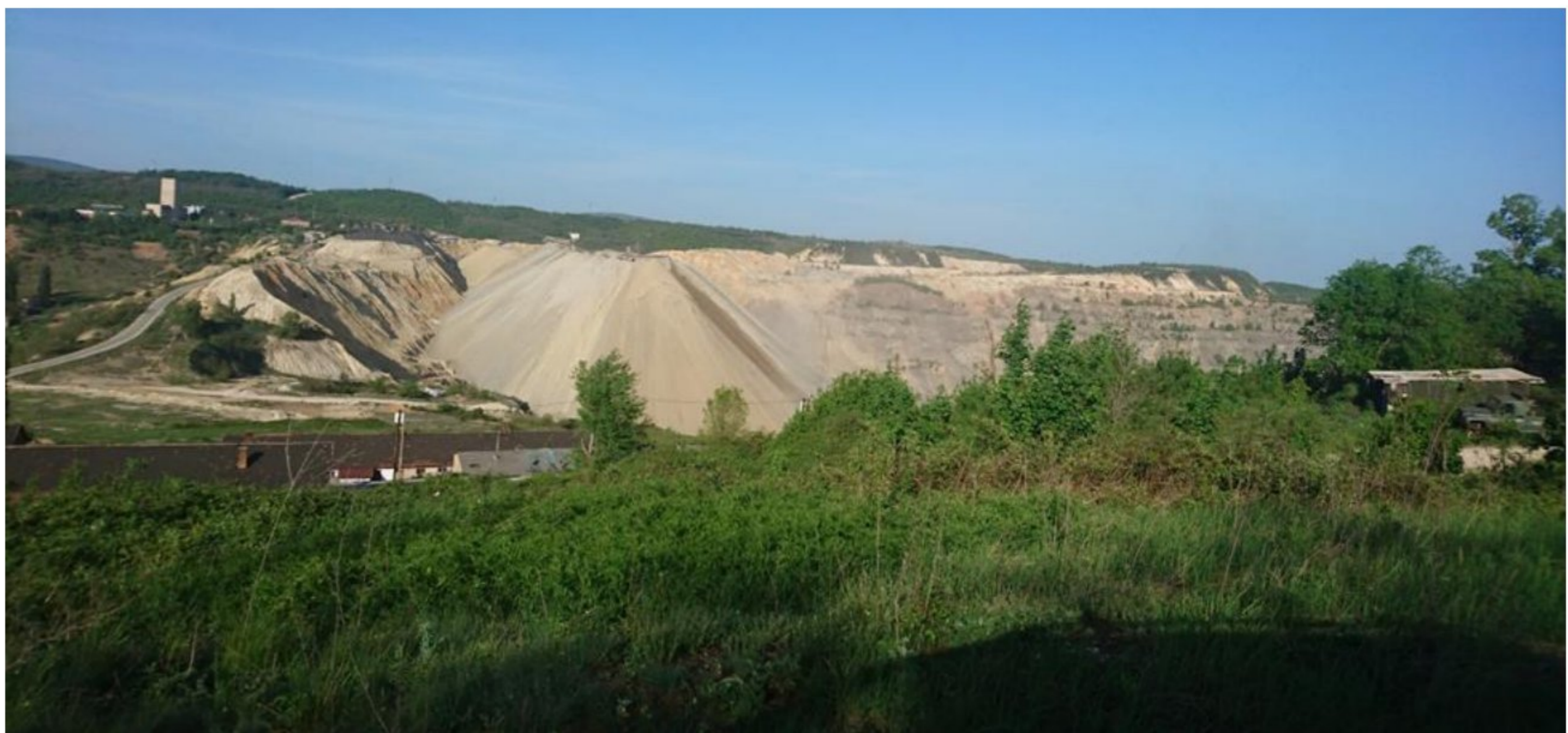
Слика 3.3.22 Једноетажно одлагалиште откопаног материјала на откопаног на површинском копу Велики Кривељ [61]
