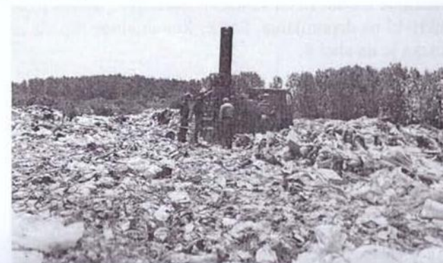
Slika 6. Izvođenje istražnog bušenja na deponiji komunalnog otpada - Plandište
