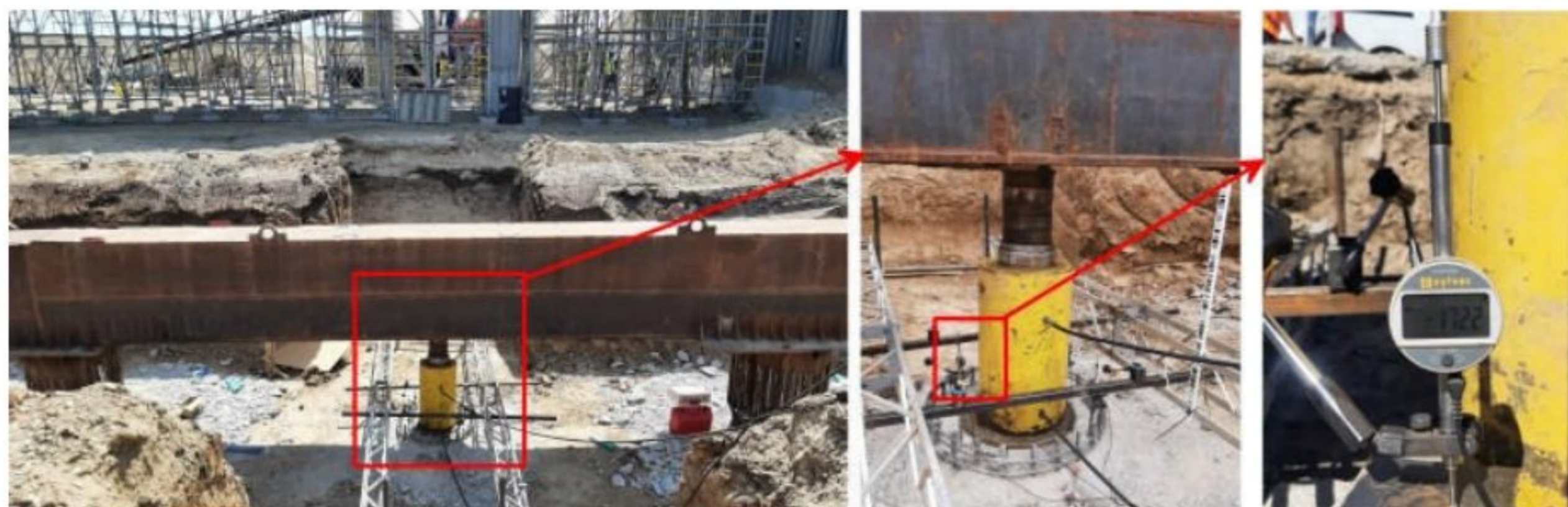
Slika 7. Konstrukcija sistema za opit probnog opterećenja šipa
